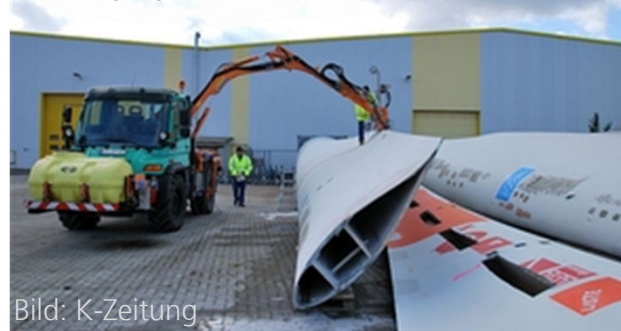
Vorzerlegung von Rotorblättern
