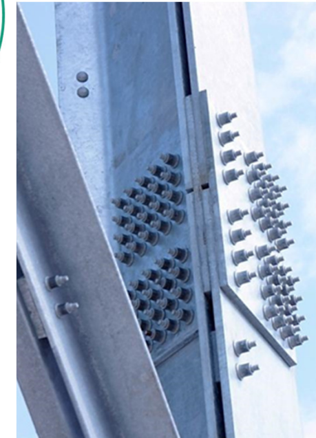
Gittermast mit Schließringbolzen (oben)
